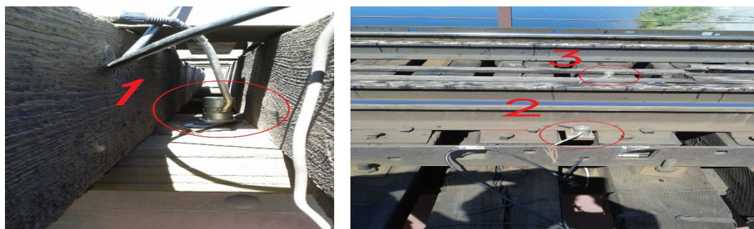
1 – середина балочного пролетного строения; 2- подошва рельса; 3- середина деревянного бруса.
